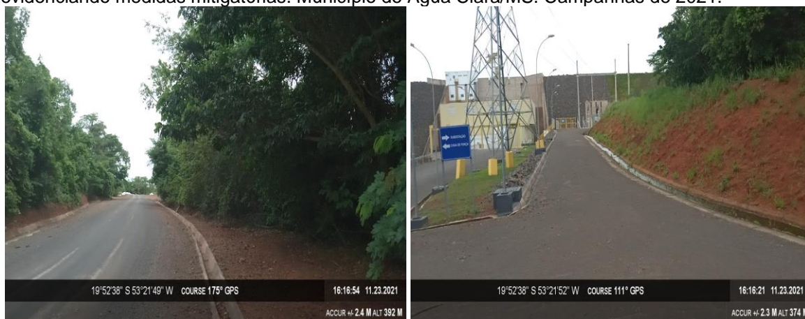
Figura 10 – Presença de canaletas para escoamento de água nas vias de acesso da PCH Verde 4A, evidenciando medidas mitigatórias. Município de Água Clara/MS. Campanhas de 2021.
