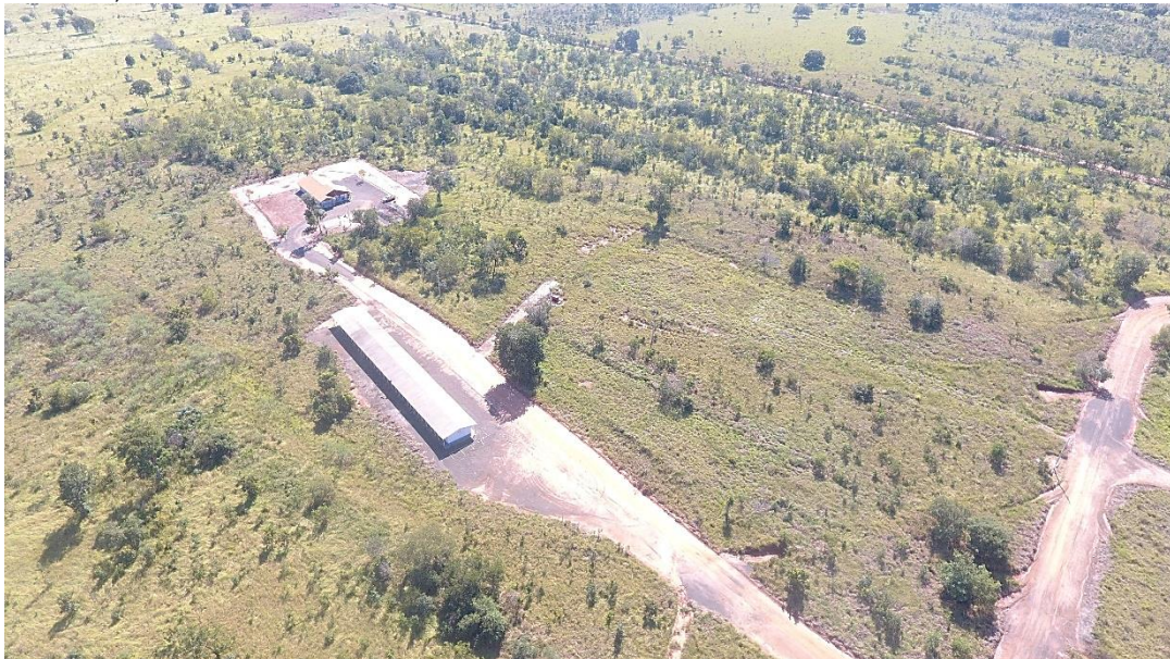
Figura 8. Imagem aérea e terrestre da área do antigo bloco dos alojamentos operacionais. PRADE - PCH Verde 4A, novembro de 2021.
