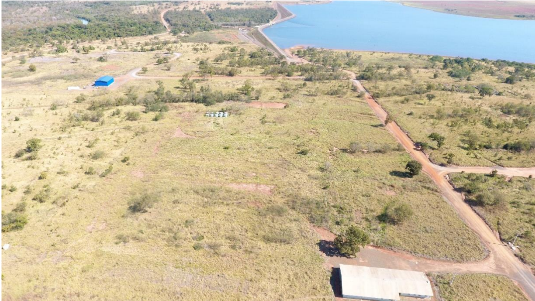
Figura 5. Imagem aérea e terrestre da área do antigo bloco dos alojamentos operacionais. PRADE - PCH Verde 4A, maio de 2021.
