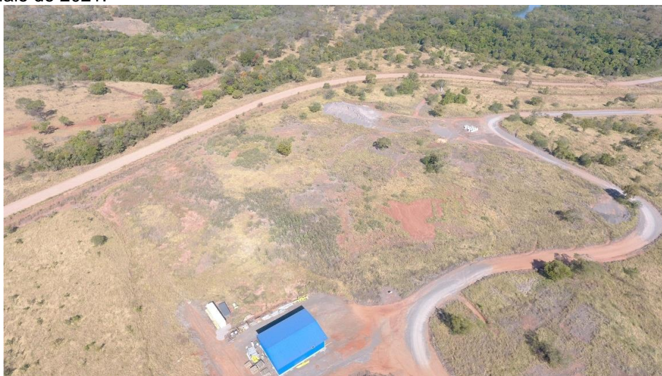
Figura 11. Imagem aérea da área próxima ao almoxarifado. PRADE - PCH Verde 4A. A) julho de 2020, B) maio de 2021.
