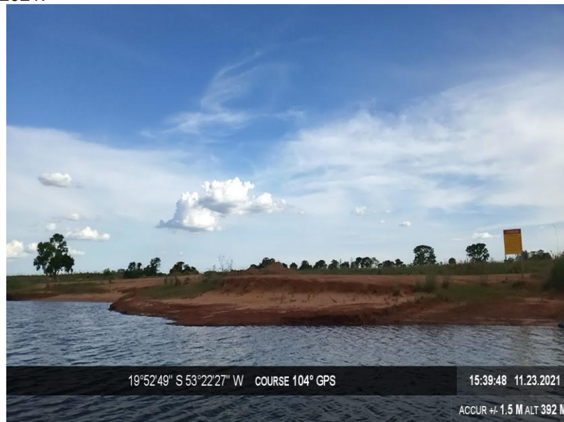
Figura 5 – Ponto 3: Erosão em sulcos, área 1 da PCH Verde 4, no município de Água Clara/MS. Campanhas de 2021.
