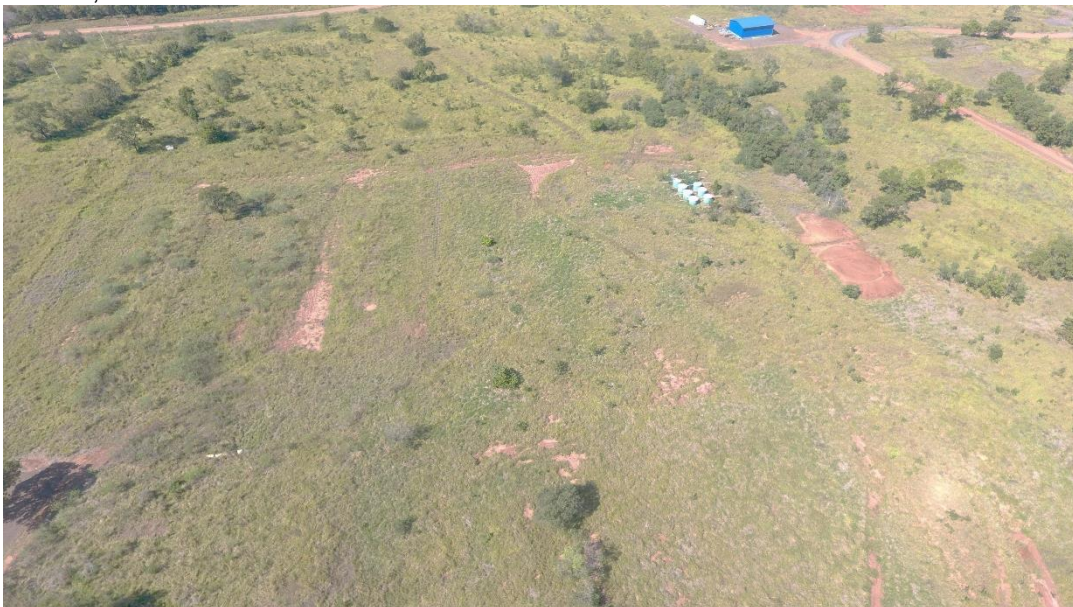
Figura 6. Imagem aérea e terrestre da área do antigo bloco dos alojamentos operacionais. PRADE - PCH Verde 4A, novembro de 2021.
