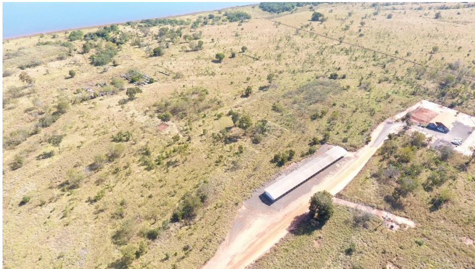
Figura 7. Imagem aérea da área do antigo bloco dos alojamentos operacionais. PRADE - PCH Verde 4A, maio de 2021.
